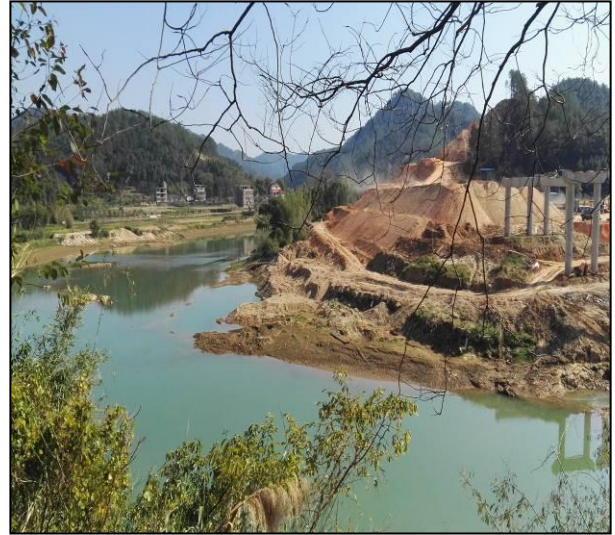
项目取水口选址现状
