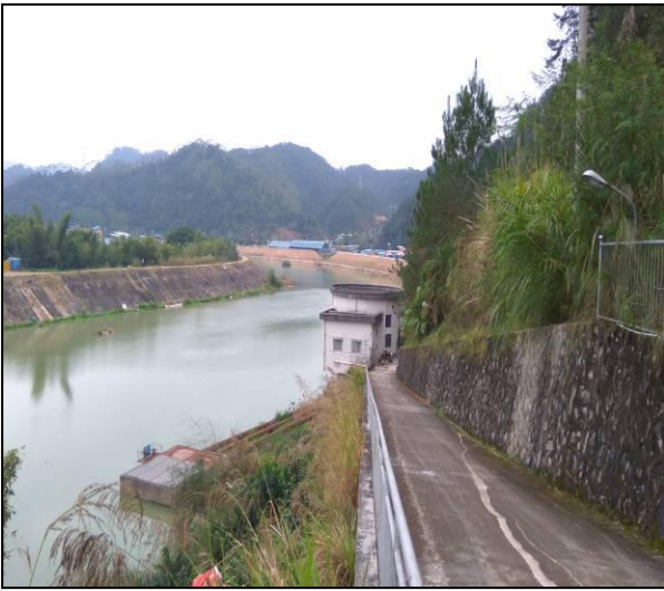
项目原取水泵站现状
