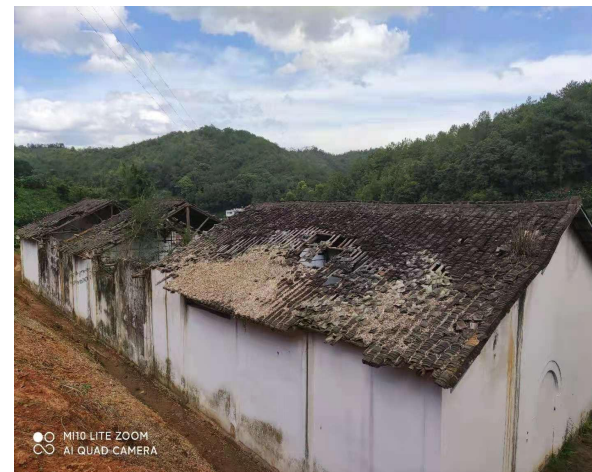
项目仓库现状
