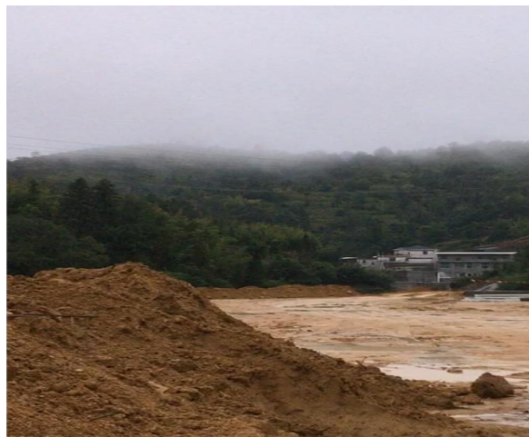
项目南面山体及进场道路
