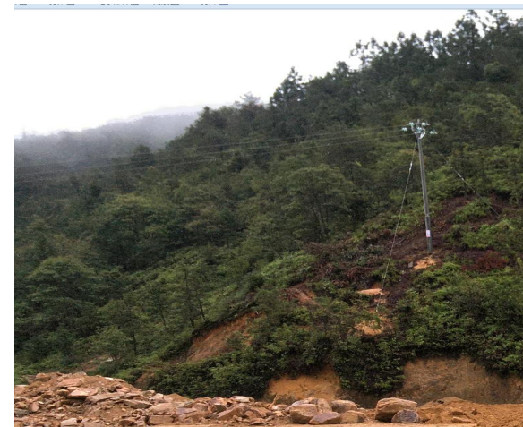
项目西面山体
