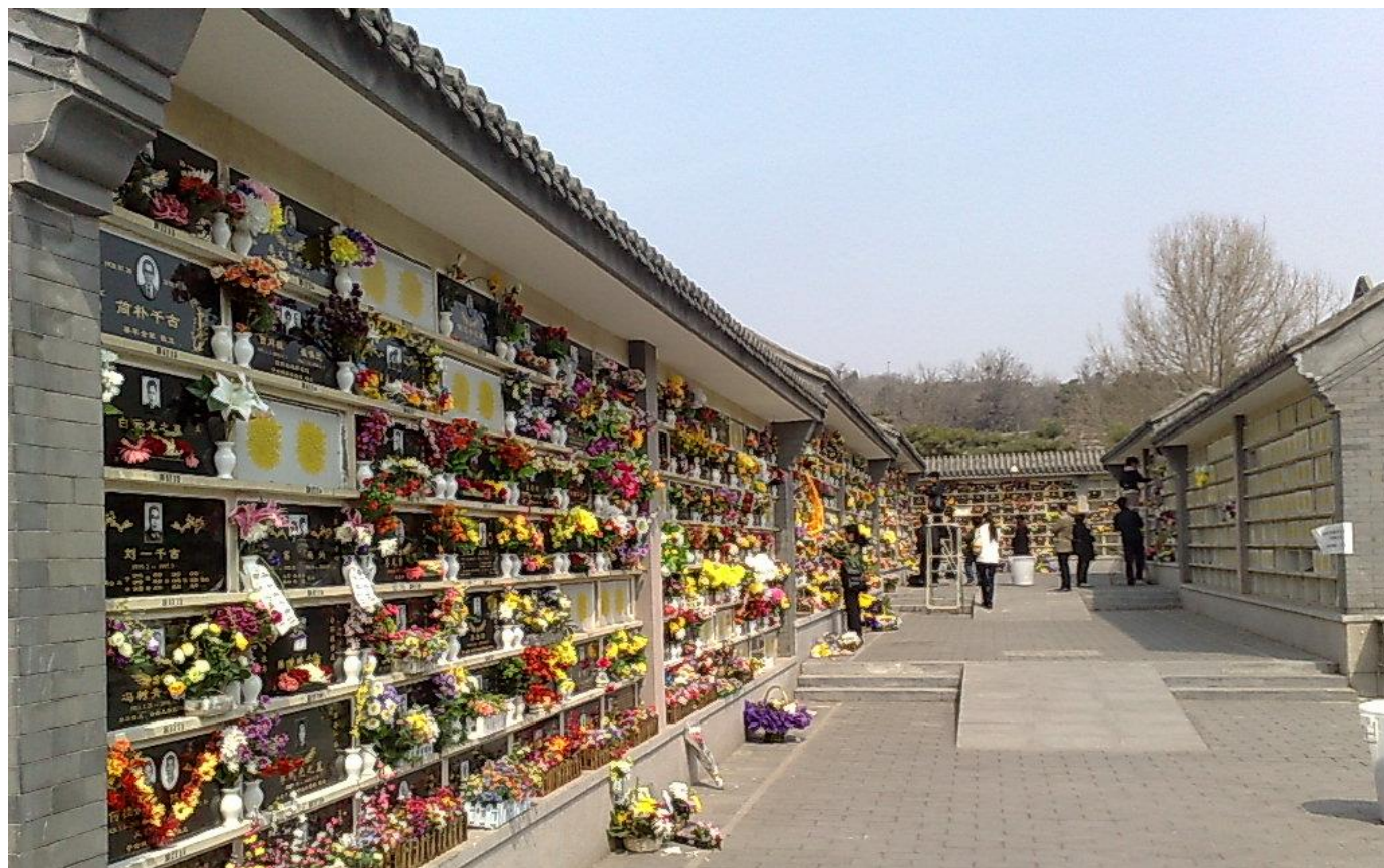
存放骨灰设备——骨灰墙
