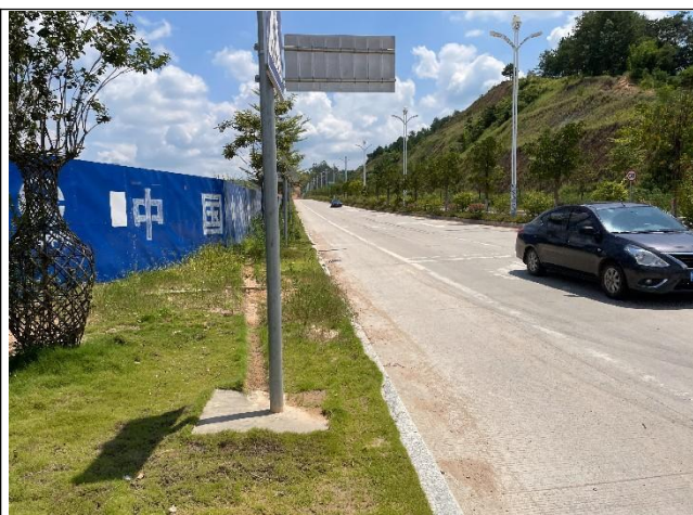
项目东南面高陂大道及山体
