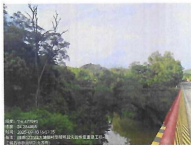
银江横石桥断面 W2-北方向
