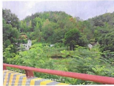
银江横石桥断面 W2-西方向
