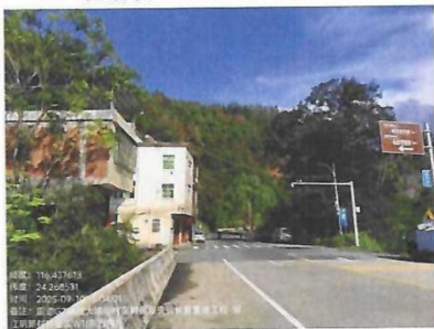
银江明新村断面 W1-东方向
