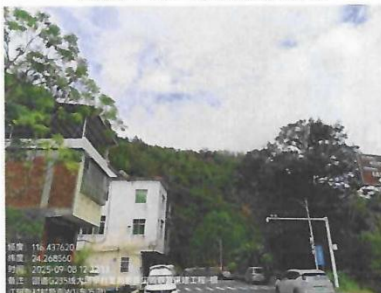
银江明新村断面 W1-东方向
