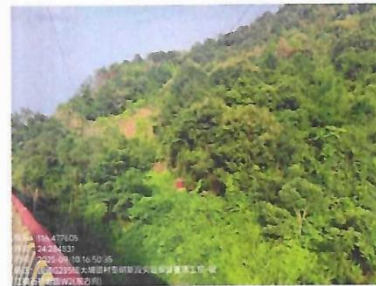
银江横石桥断面 W2-东方向
