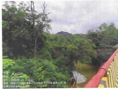
银江横石桥断面 W2-北方向
