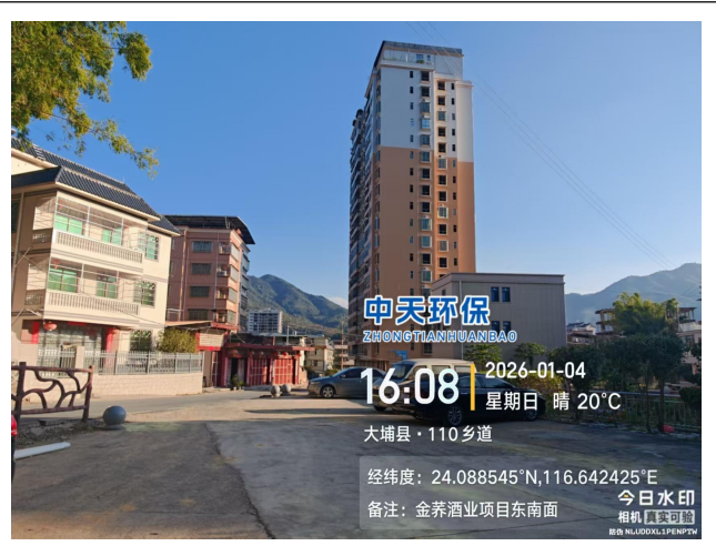
项目东南面（厂区入口）
