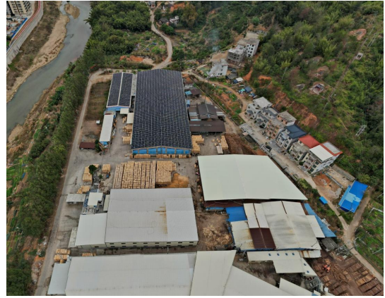
项目南面——大埔县富华木业有限公司
