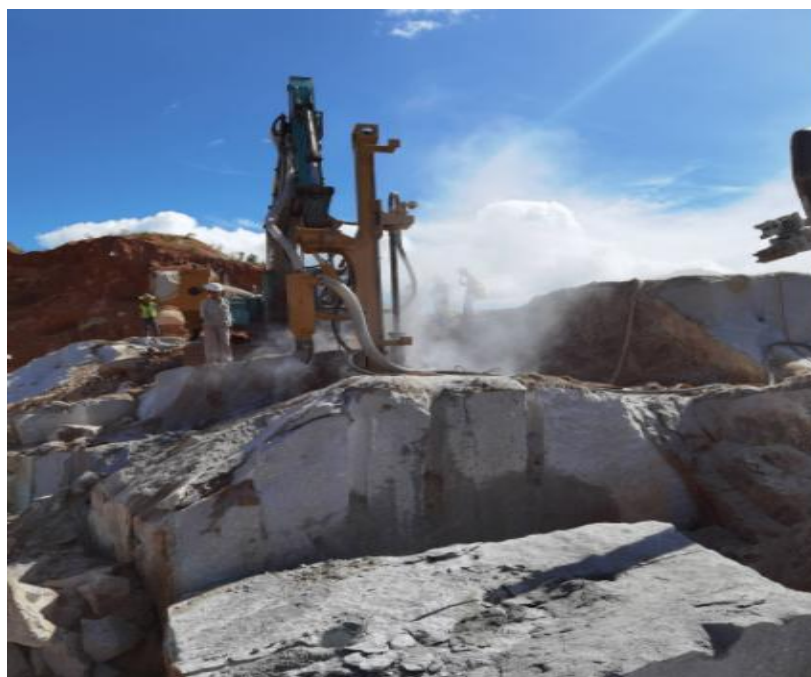
图 4-2 液压分裂棒静态破碎岩石工法示意图
